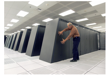
Abb. 30: Supercomputer in einem Forschungszentrum (USA).
