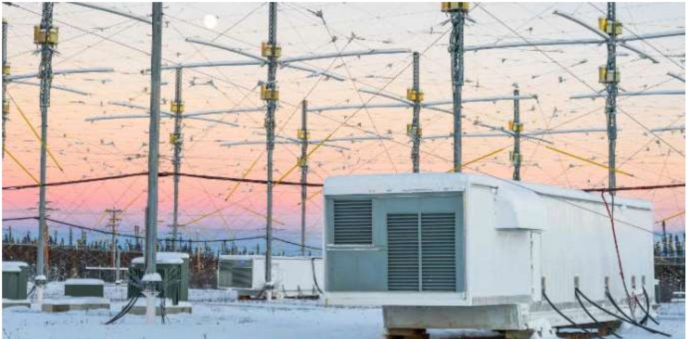
Das Antennenfeld aus der Nähe.
