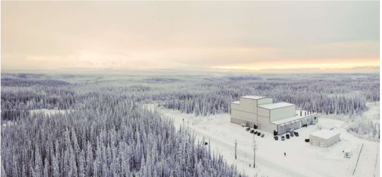
Die Kommandozentrale der HAARP-Anlage. Von hier wird sie gesteuert und koordiniert.
