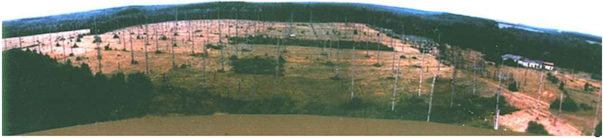
Die Sura Anlage in Russland.
